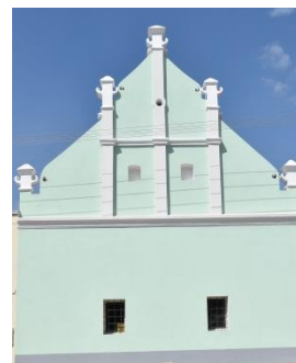
renesanční štít jižního průčelí původního panského dvora (čp. 1)
