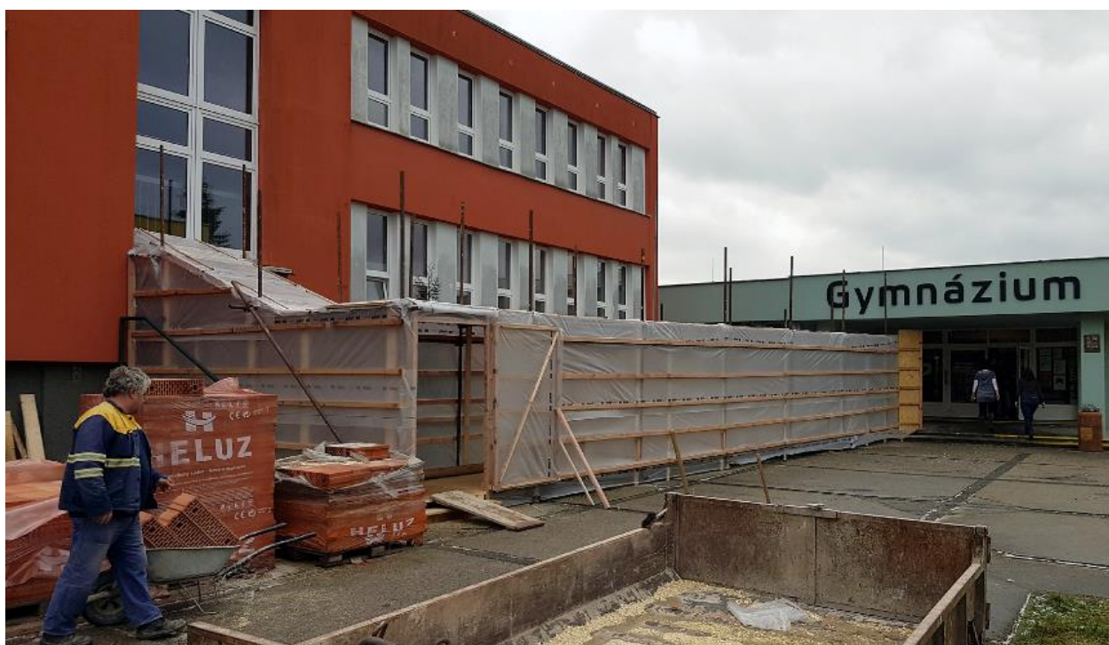
Provizorní spojovací koridor
