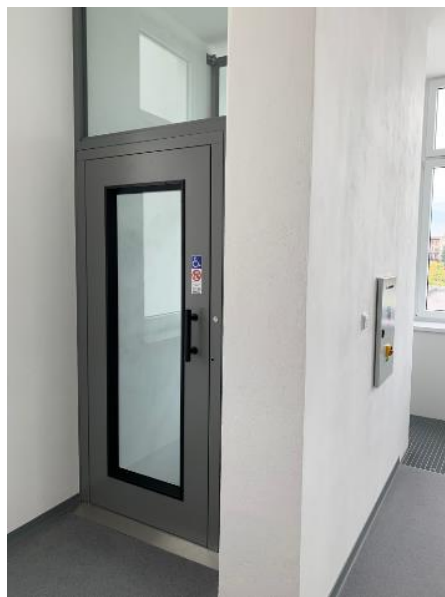
Finální realizace svislé výtahové plošiny v učebním pavilonu U1
