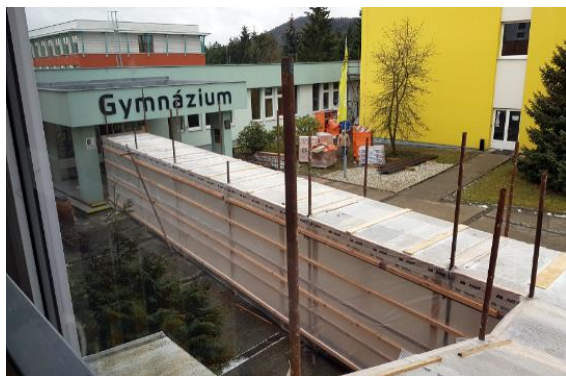
Provizorní spojovací krček během stavebních prací na bezbariérovém gymnáziu
