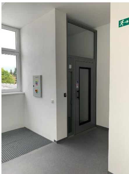
Finální realizace svislé výtahové plošiny v učebním pavilonu U1
