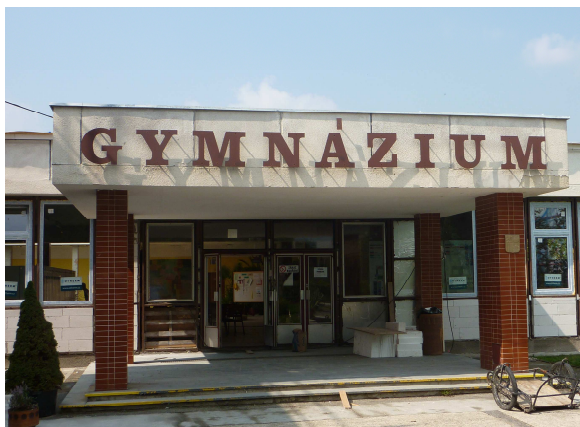
Vchod před rekonstrukcí ...
