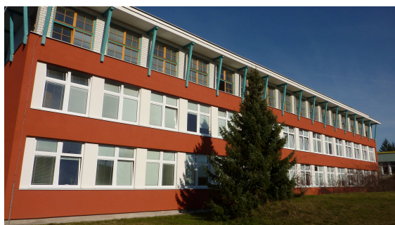
... a po rekonstrukci
