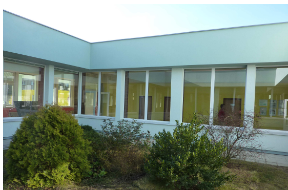
... a po rekonstrukci
