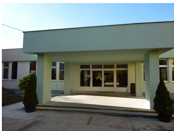
... a po rekonstrukci
